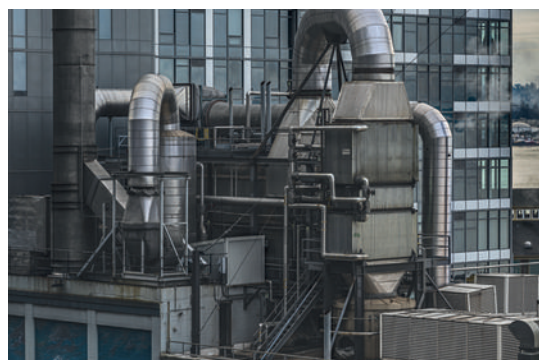
Torre di lavaggio
